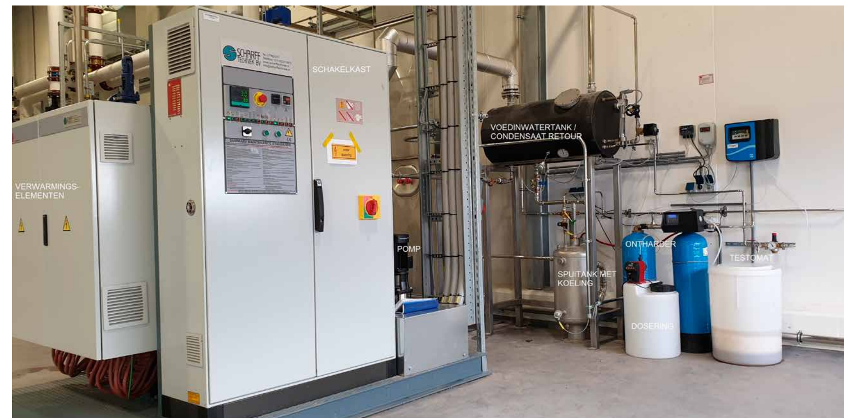
Praktijkopstelling van een elektrische stoomketel van Scharff (Foto: Scharff Techniek).
